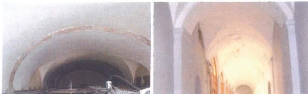
Bóvedas de arista y de cañón en techo planta baja
