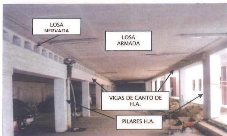
Vistas de la estructura de acceso a sótano y aparcamientos
