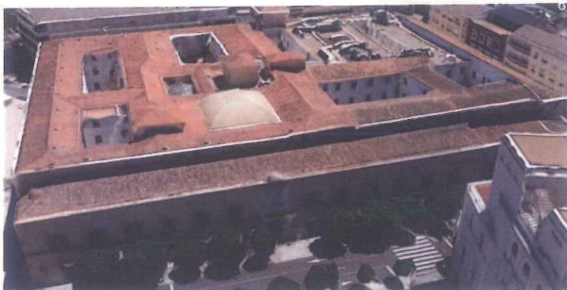
Vistas aérea del edificio. Fachada principal. Calle San Pedro de Valdivia
