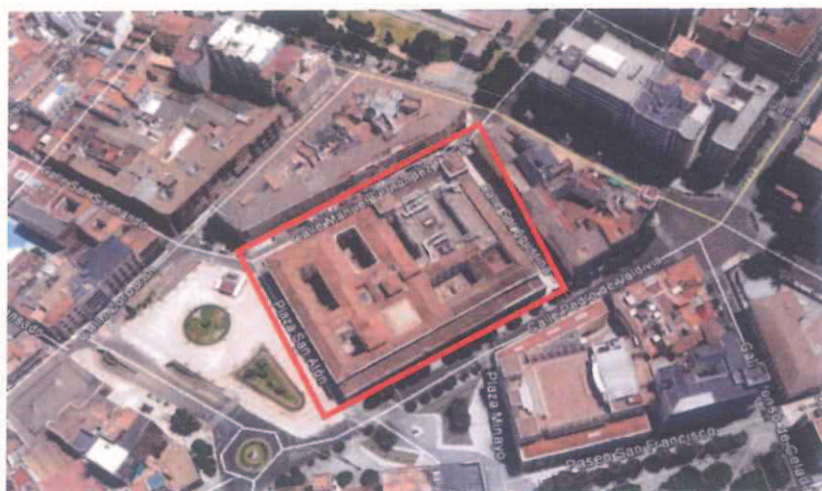
Imagen aérea. Situación del inmueble
