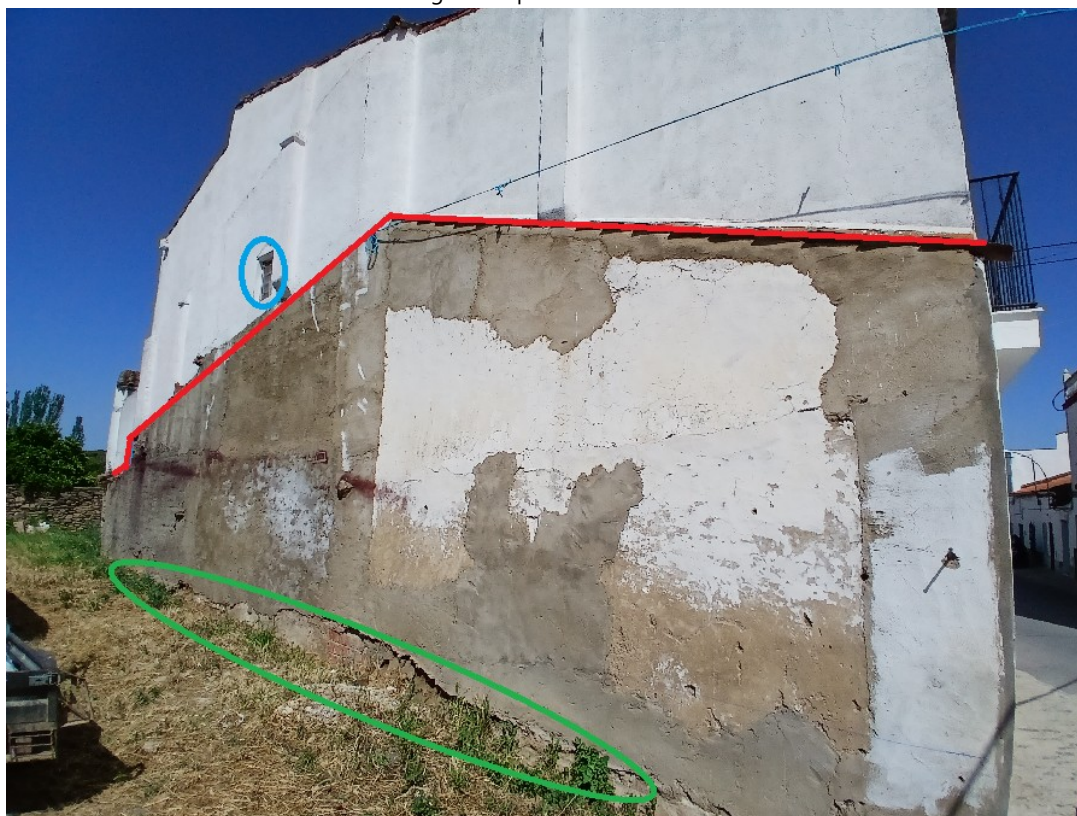
Vistas general pared medianera.
